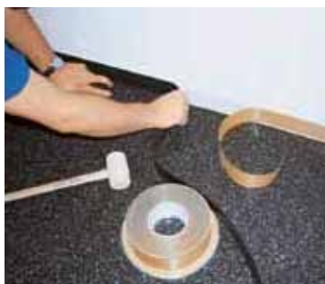
Obróbka listew przyściennych nora®
