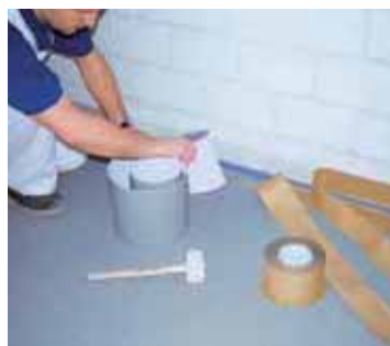
Cokoły z kauczukowej wykładziny podłogowej noraplan®, wywijane na ścianę.
