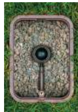
Zamontowany Automatyczny Zawór Płuczący
