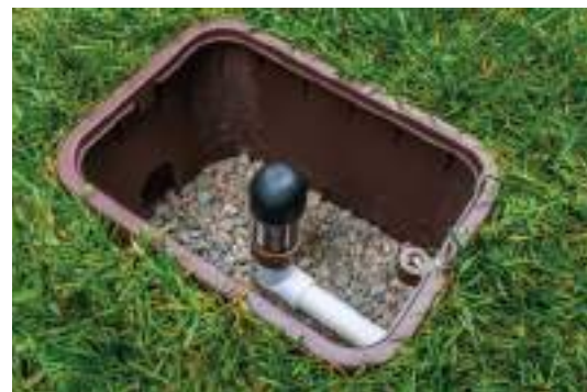
Zamontowany Zawór Odpowietrzający/Próżniowy
