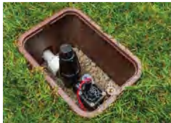
PCZ-101 zainstalowany w skrzynce uniwersalnej
