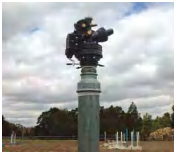
Zainstalowana dysza ST-1600-HS-BR
