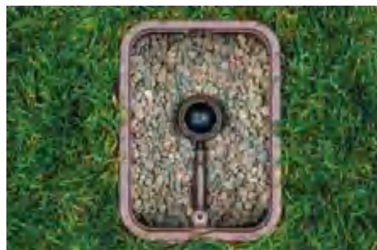
Zamontowany automatyczny zawór płuczący
