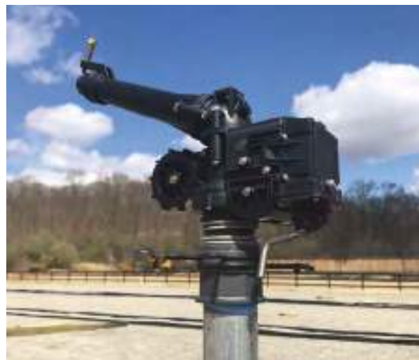
Zainstalowany Rotor ST-1200-BR
